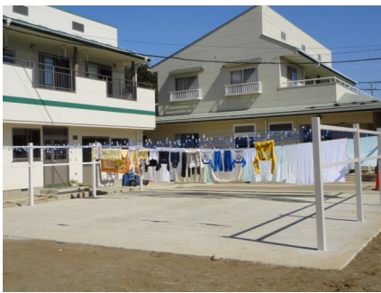
コンクリートで遮蔽した洗濯物干し場
