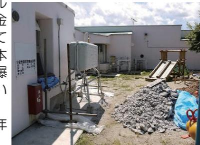
防油堤コンクリート基礎取り替え工事
