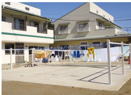
改修工事後の洗濯物干し場(2013年)
